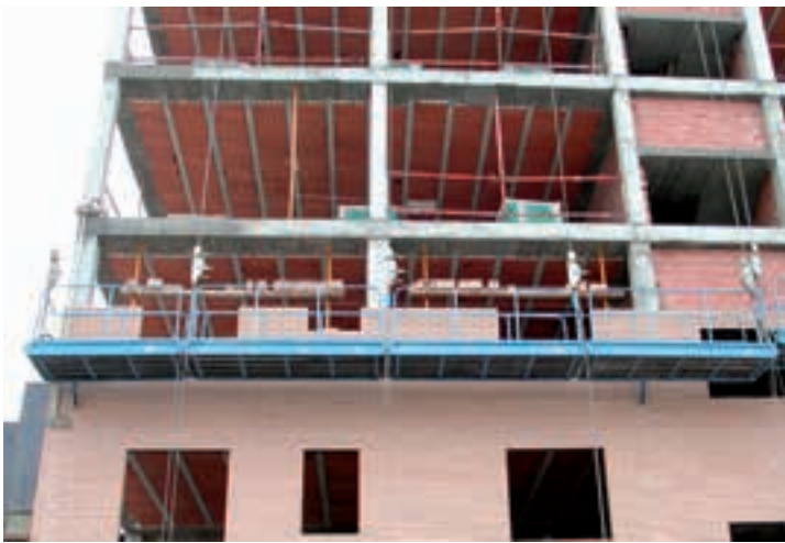
Figura 1. Fachada de obra vista de fábrica cerámica
