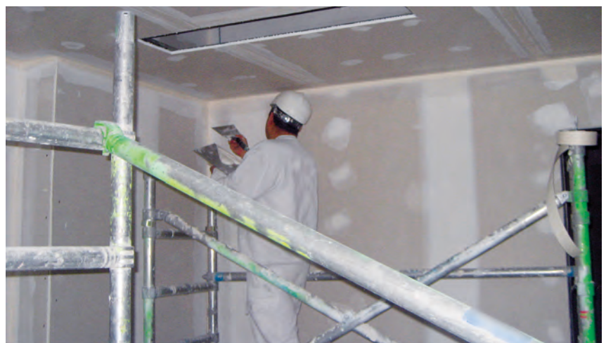
Figura 2. Colocador de placas de yeso laminado
