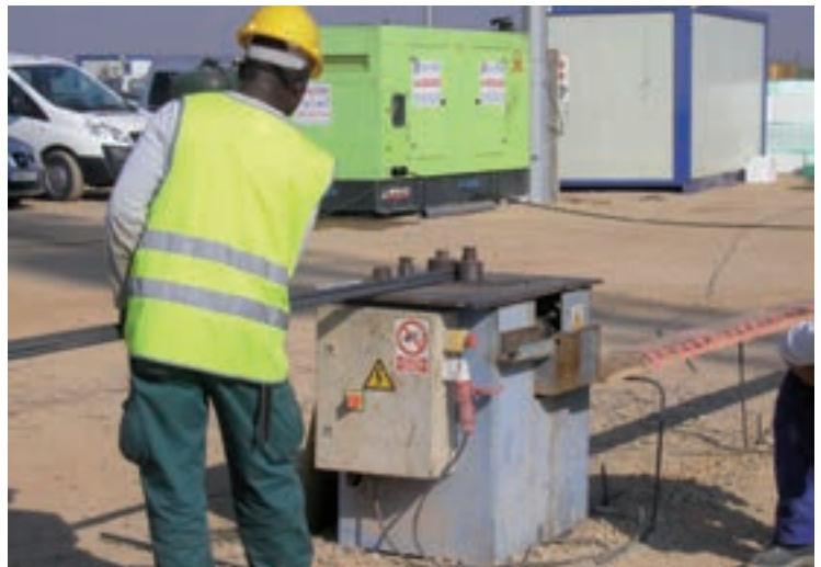
Figura 1. Operación de doblado de ferralla
