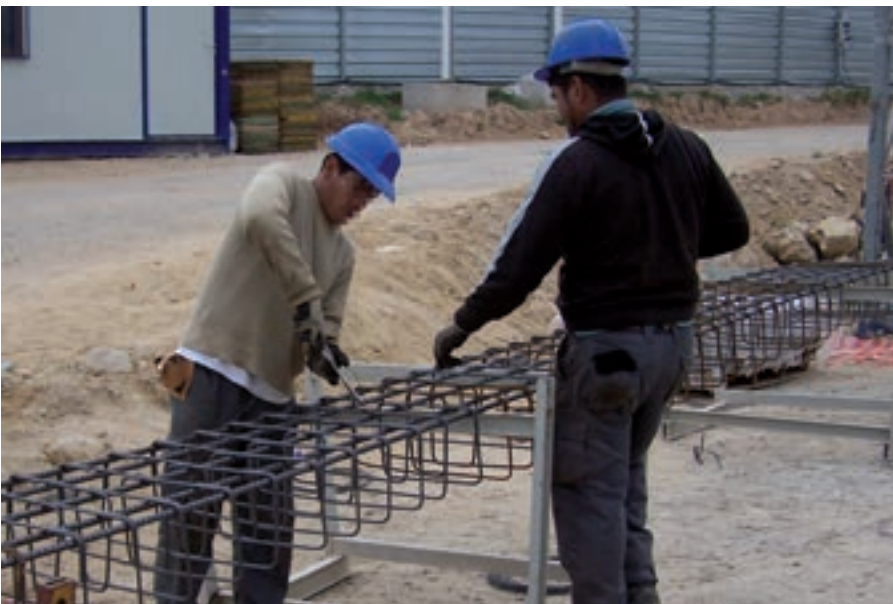
Figura 4. Atado manual de armaduras
