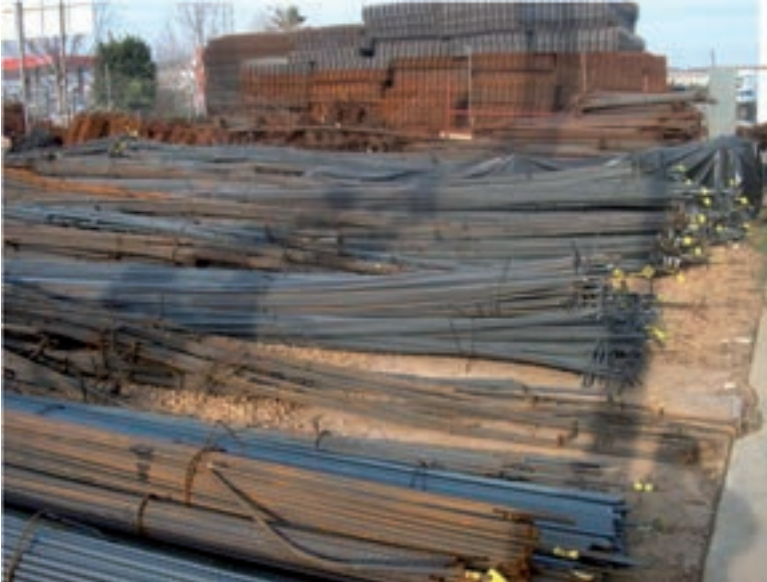
Figura 7. Acopio de ferralla
