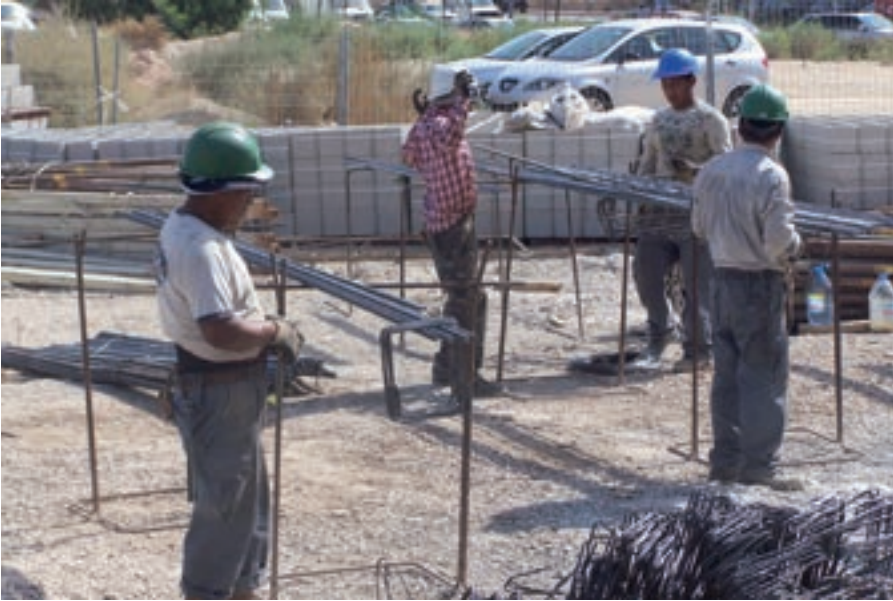
Figura 3. Unión de armaduras mediante atado por alambre
