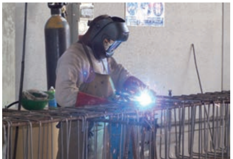
Figura 2. Unión de armaduras mediante soldadura
