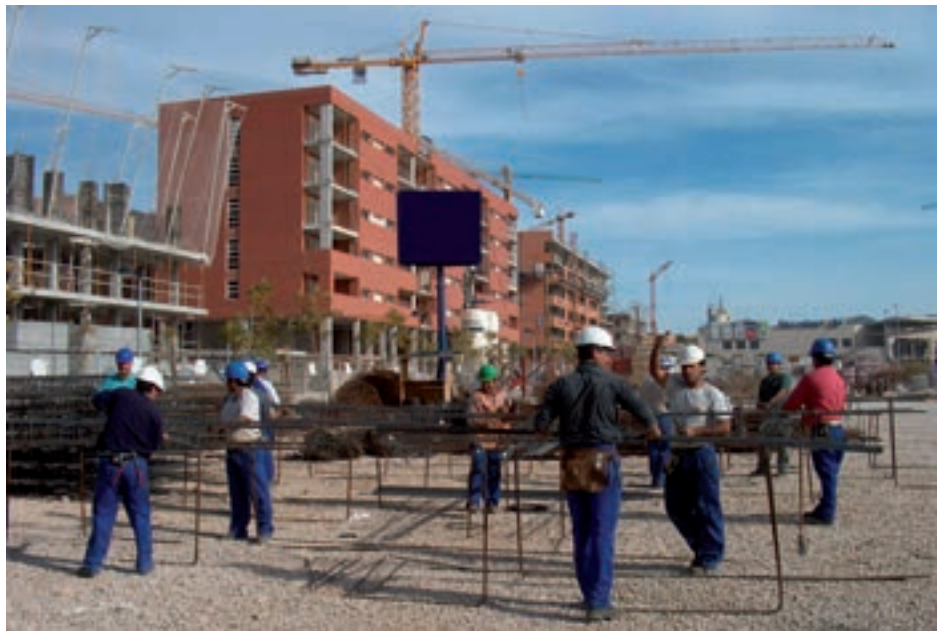
Figura 6 Taller de ferrallado en obra
