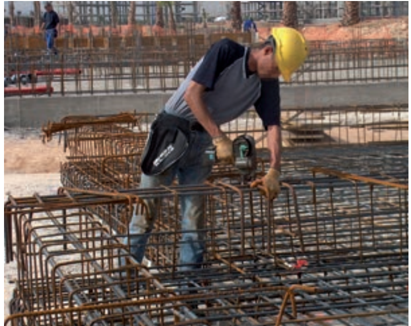
Figura 5 Atado mecánico de armaduras
