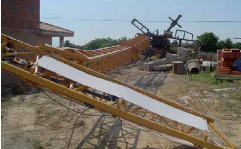
Figura 1. Accidente de grúa autodesplegable
