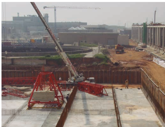
Figura 2. Inicio del montaje de una grúa torre
