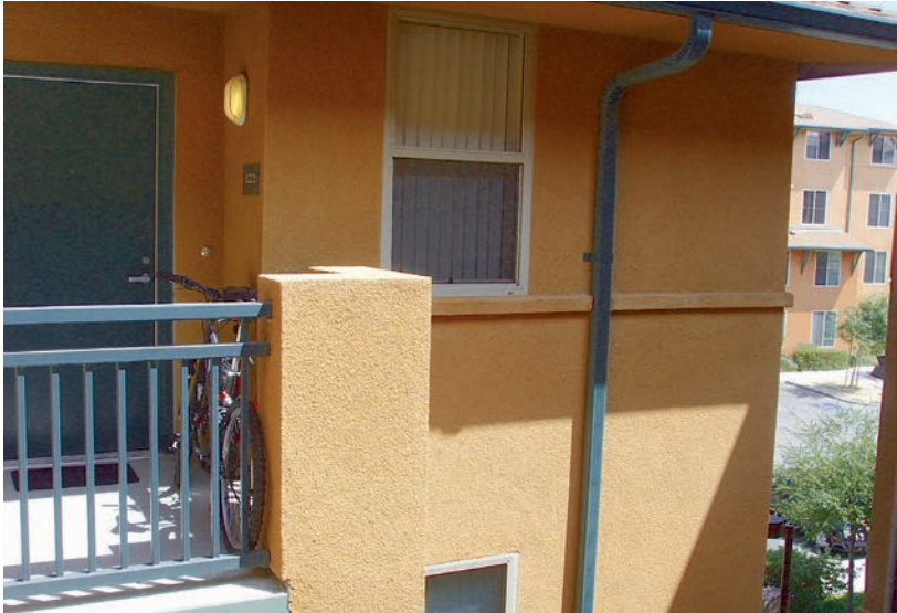
Figura 5. Monocapa en fachada. Castelldefels
