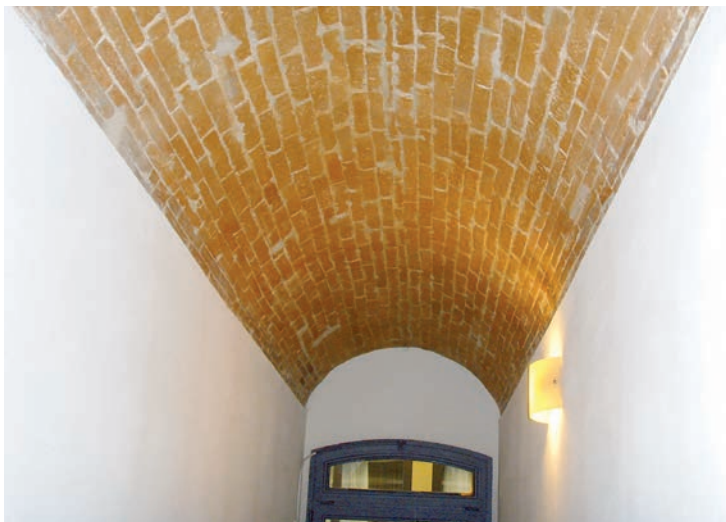
Figura 4. Yeso en paramentos. Carmona
