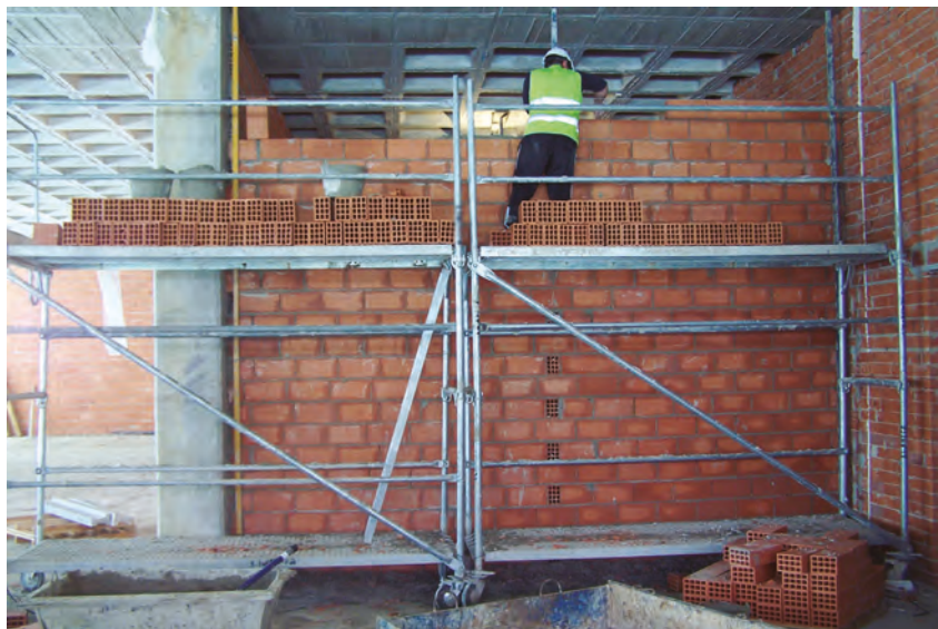
Figura 1. Ejecución de fábrica de ladrillos para revestir. Fuente: GESPRE
