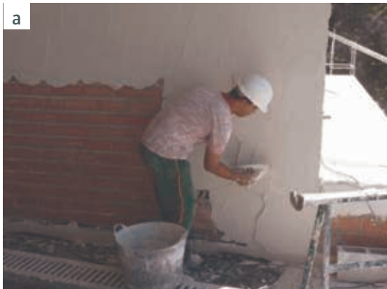
Figura 6. Guarnecido (a) y enlucido de yeso (b). Fuente: GESPRE
