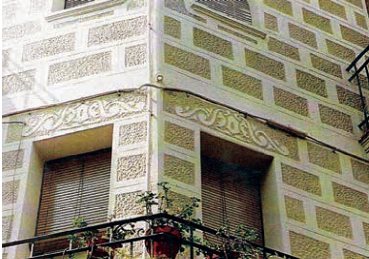
Figura 7. Revoco imitando sillares de piedra. Fuente: Javier Moreno Arnaz y Daniel García de Frutos. Revestimientos. Tornapunta Ediciones
