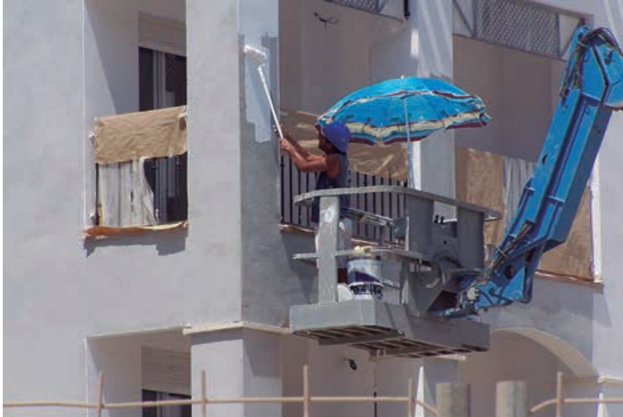
Figura 3. Trabajos de pintura en paramentos exteriores. Fuente: GESPRE
