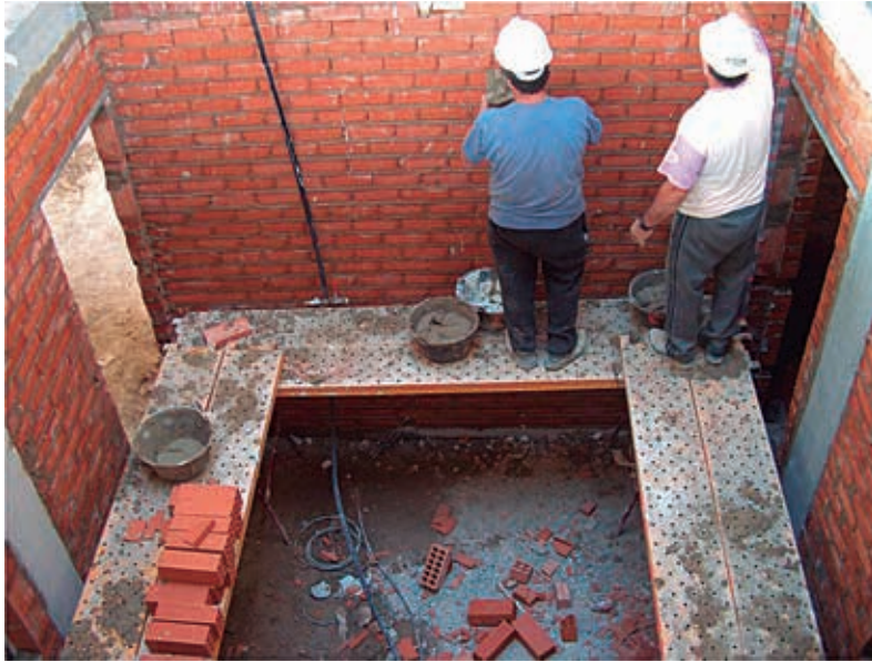
Figura 2. Fábrica de ladrillo para revestir y encuentros con los pilares y forjados de hormigón. Fuente: GESPRE
