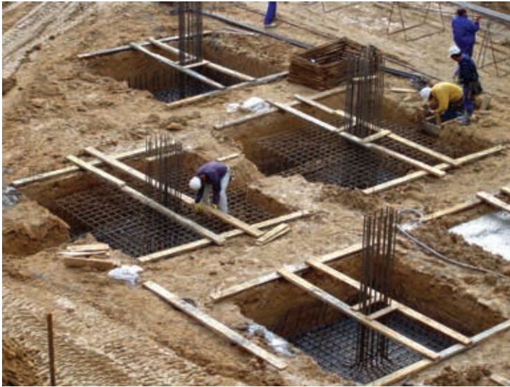
Figura 1. Vista general de un cimiento
