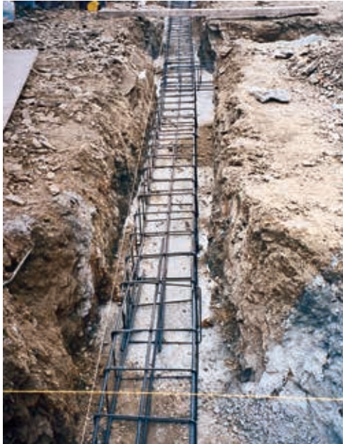
Figura 3. Cimentación superficial continua
