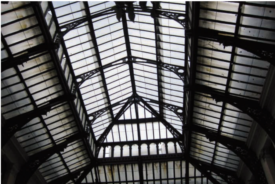
Figura 3. Estructura de hierro de un lucernario del antiguo Ministerio de Agricultura (Madrid)
