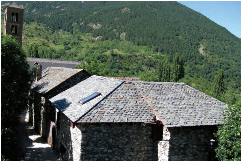
Figura 5. Cubierta inclinada de pizarra
