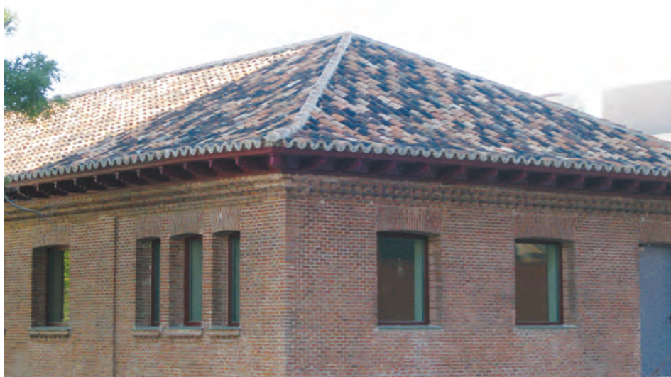
Figura 7. Cubierta inclinada de teja cerámica curva
