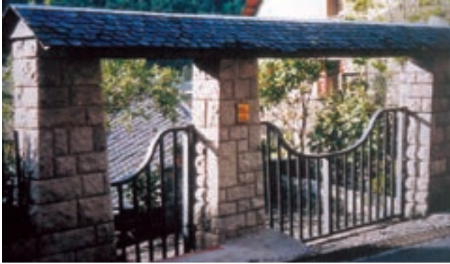
Figura 6. Pórtico de entrada realizado con sillares de distintos tamaños
