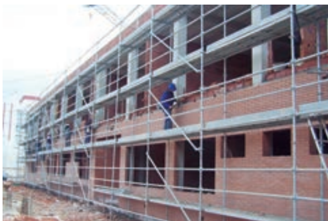
Figura 5. Ejecución de cerramiento exterior mediante obra de fábrica de ladrillo visto. Fuente: GESPRE
