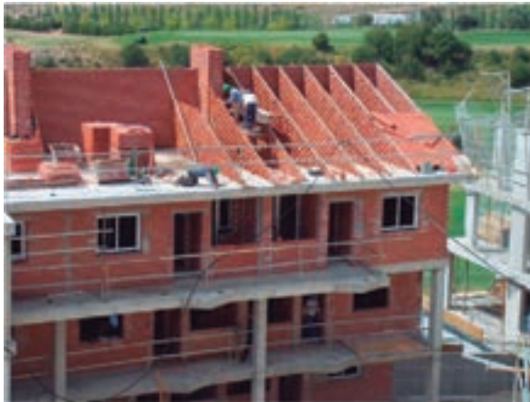
Figura 2. Ejecución de tabiques palomeros para la formación de las pendientes de una cubierta inclinada. Fuente: GESPRE
