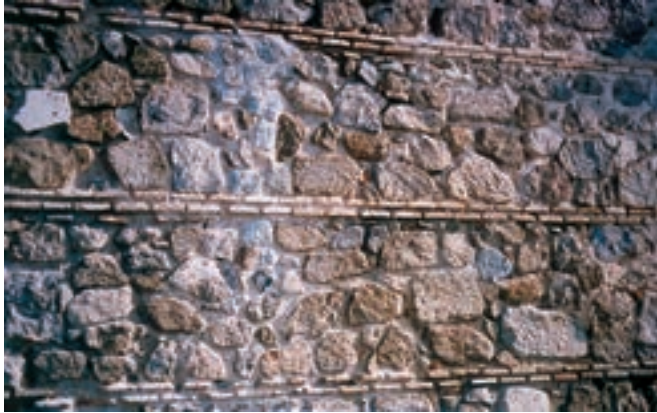
Figura 8. Muro de mampostería con verdugadas de ladrillos
