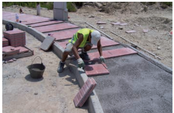
Figura 1. Solado exterior de baldosas de cemento ejecutado sobre una solera nivelada de hormigón
