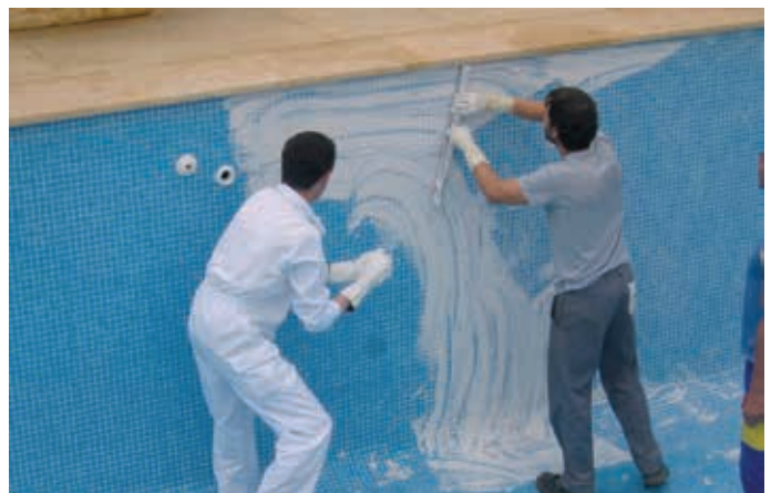
Figura 5. Proceso de rejuntado del revestimiento de gresite de una piscina
