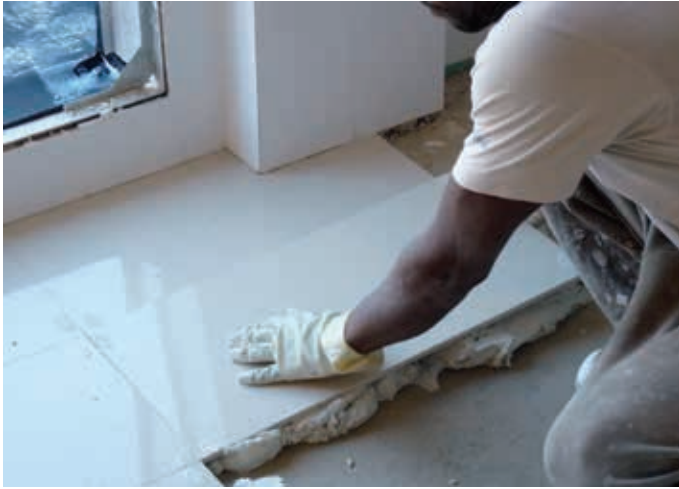
Figura 2. Solado interior mediante baldosas de gres
