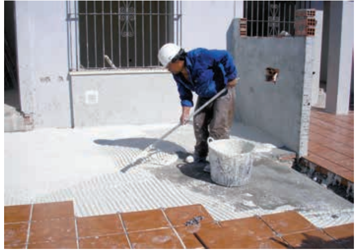
Figura 4. Solado exterior ejecutado mediante baldosas cerámicas fijadas con pasta adhesiva a la solera de hormigón
