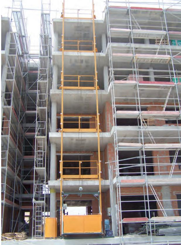
**Figura 15.** Puertas de acceso a la plataforma del montacargas en las plantas del edificio.
