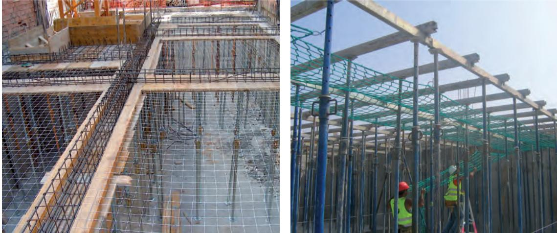
**Figura 7.** *Sistemas de red bajo forjado*
