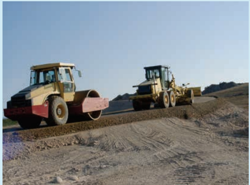
Figura 5. Extendido y compactado
