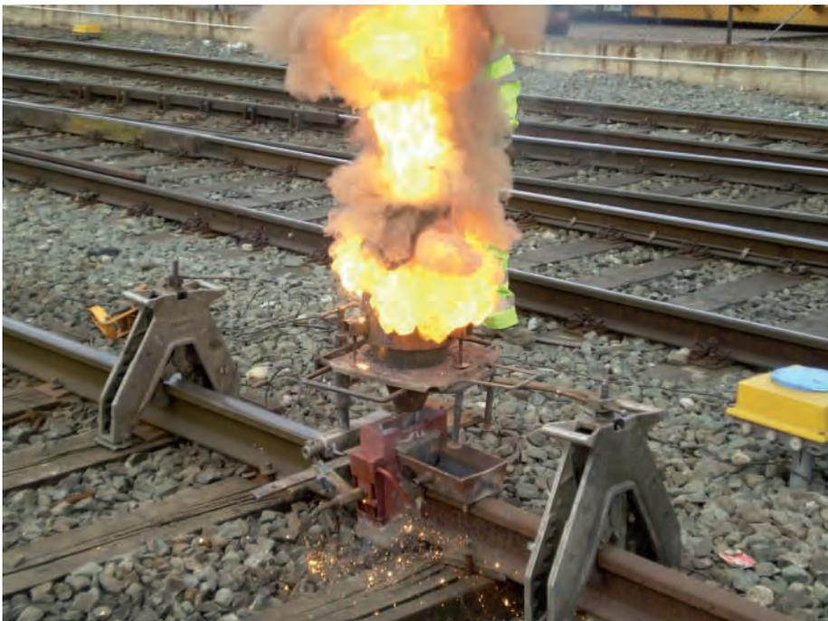
Figura 9. Soldadura aluminotérmica. Fuente:TECSA
