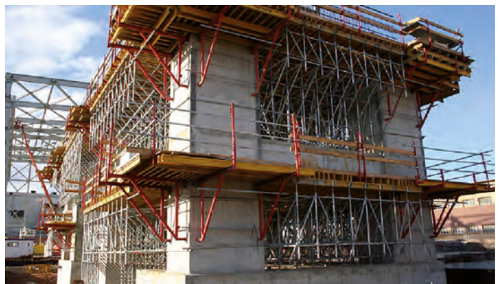
Figura 3. Cimbras para el apuntalamiento del encofrado. Fuente: Encofrados J. Alsina, S.A.
