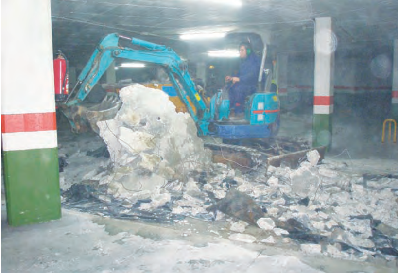
Figura 3. Retroexcavadora. Fuente: APA
