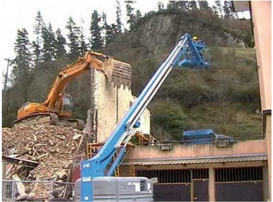
Figura 6. Demolición mediante empuje o tracción con la retroexcavadora. Fuente: GESPRE, S.L.
