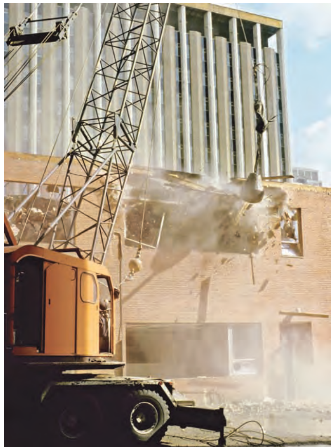
Figura 5. Demolición con bola. Fuente: APA
