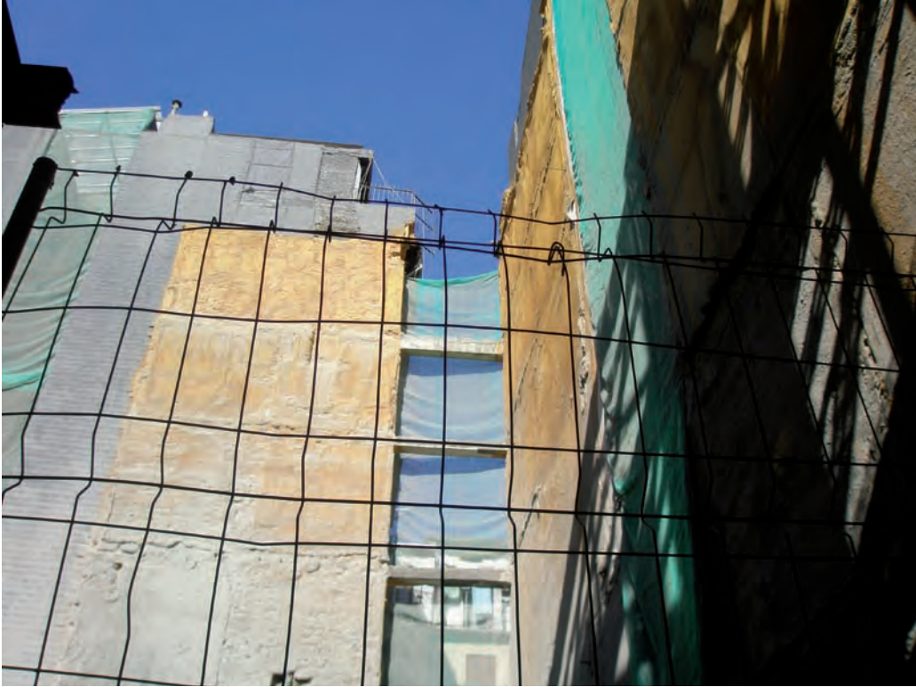
Figura 2. Edificio que se ha demolido quedando a la vista las fachadas laterales de los edificios colindantes. Fuente: APA
