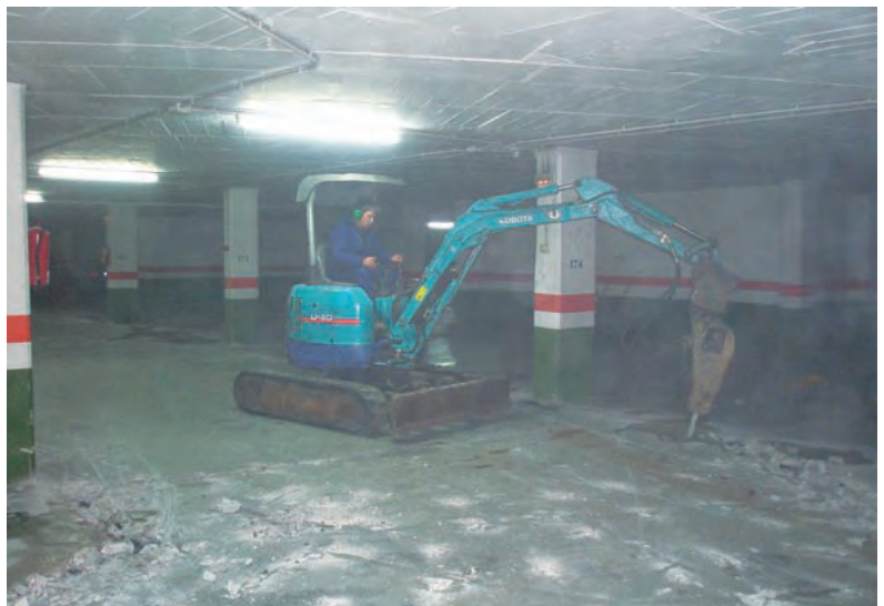
Figura 1. Demolición de un pavimento de hormigón con máquina. Fuente: APA
