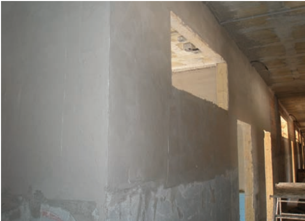
Figura 4. Paramento vertical con el enlucido aplicado
