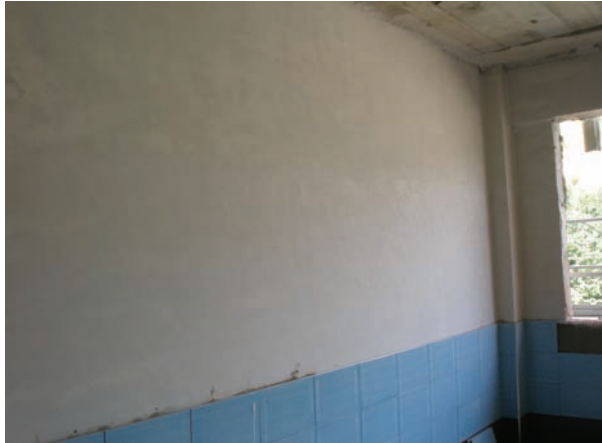
Figura 3. Revestimiento ejecutado de guarnecido y enlucido
