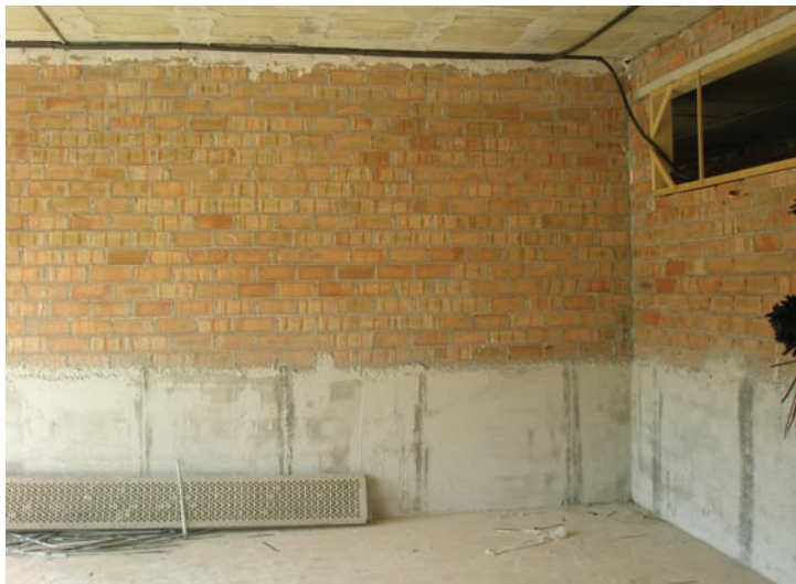
Figura 2. Paredes preparadas para ejecutar el revestimiento de yeso
