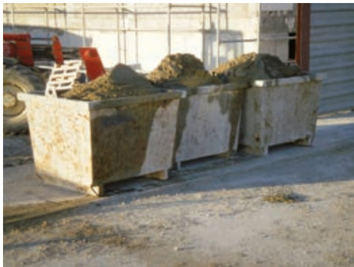
Figura 2. Mortero húmedo o fresco preparado en fábrica
