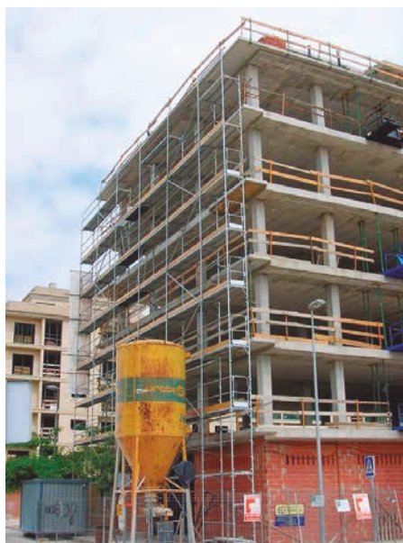
Figura 3. Almacenaje del mortero suministrado a granel en un silo a pie de obra.
