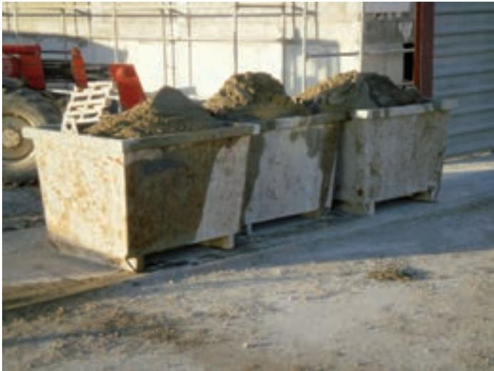
**Figura 2.** Mortero húmedo o fresco preparado en fábrica
