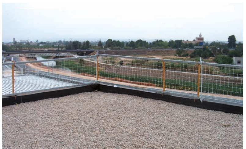
Figura 7. Red de seguridad como protección intermedia en la protección de borde
