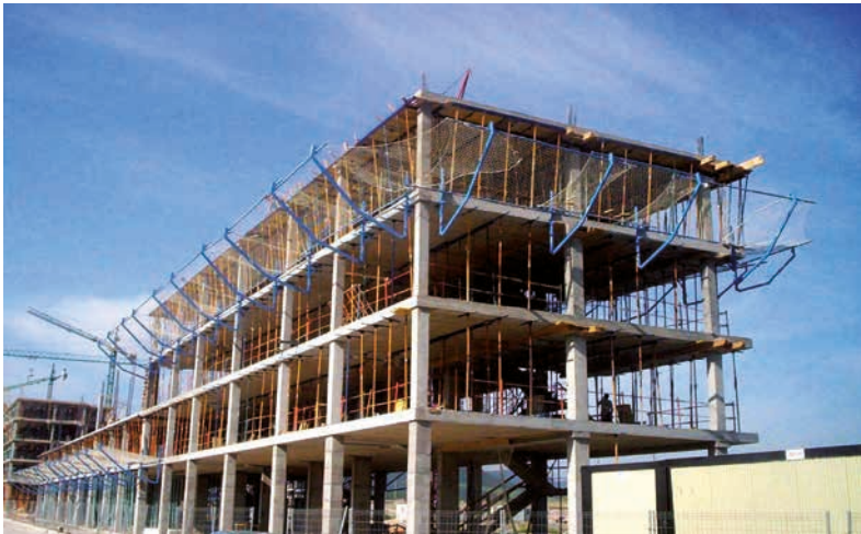
Figura 4. Red de bandeja durante la ejecución de la estructura del edificio
