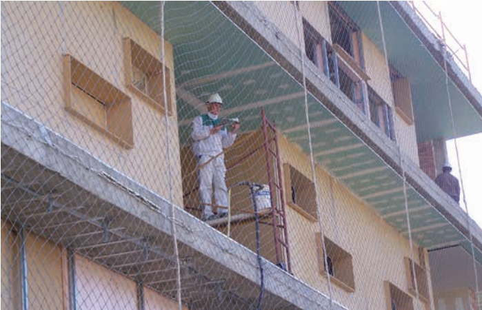
Figura 8. Red vertical anclada al canto de los forjados
