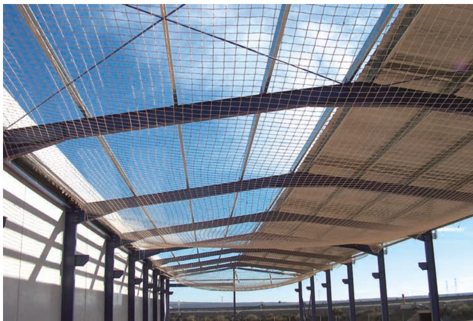
Figura 3. Red de seguridad horizontal bajo la estructura de la cubierta
