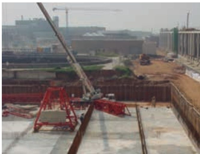
Figura 2. Inicio del montaje de una grúa torre
