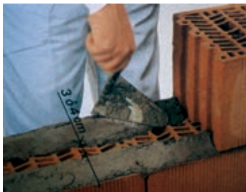
Figura 7. Pieza de Termoarcilla
