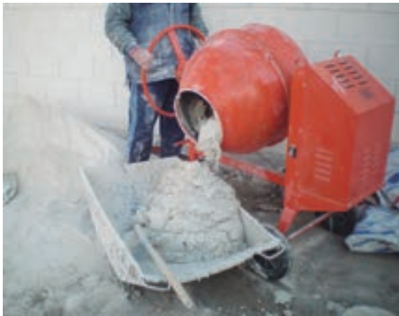
Figura 12. Amasado mediante hormigonera.
