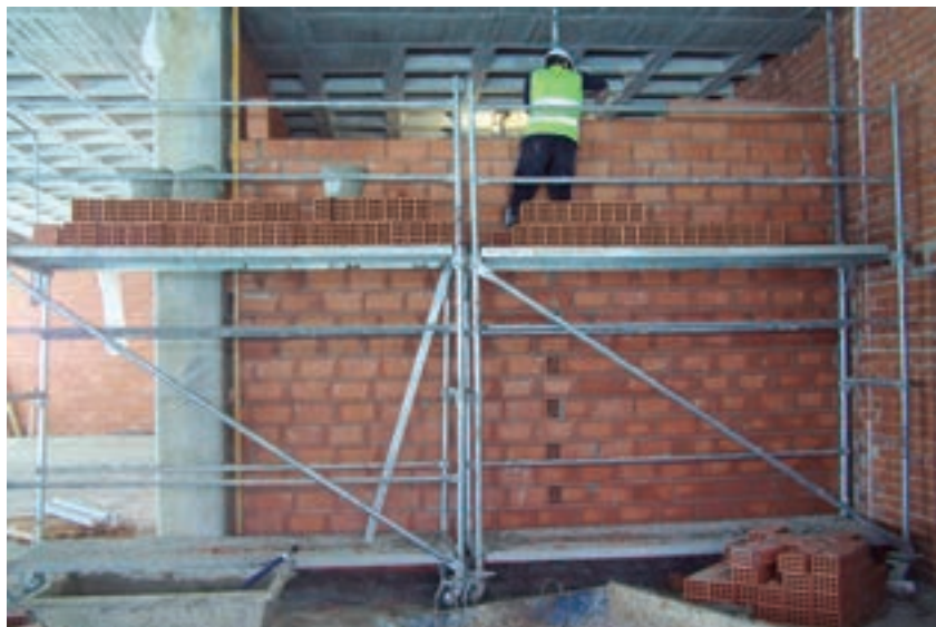
Figura 1. Ejecución de fábrica de ladrillos para revestir. Fuente: GESPRES
