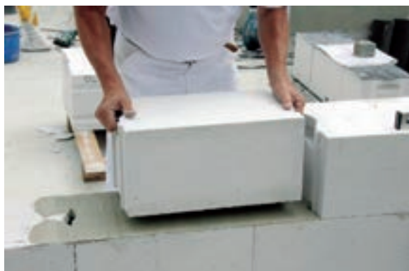
Figura 10. Bloques de hormigón celular curados en autoclave. Fuente: www.ytong.es
