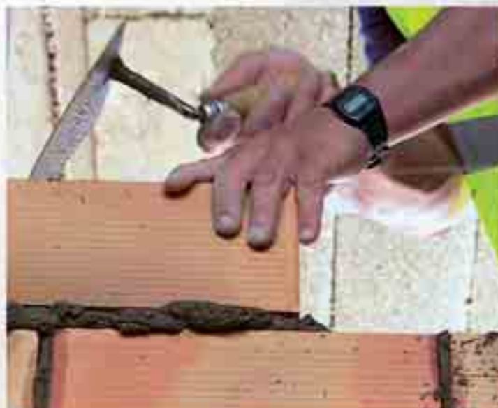
Ejecución de obra de ladrillo
