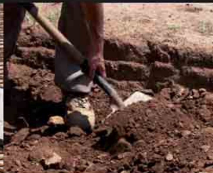
Realización de zanja horizontal de saneamiento
