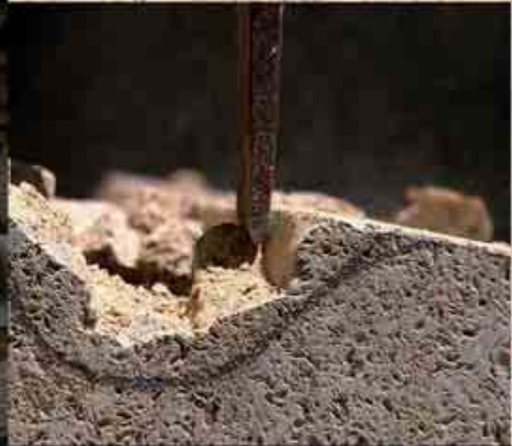
Desbaste con disco de diamante y con cincel
