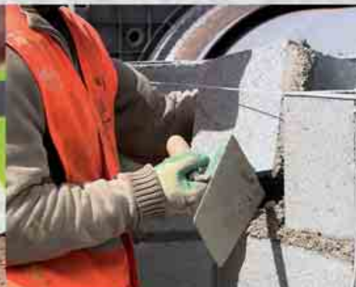
Recibido de bloque de hormigón
