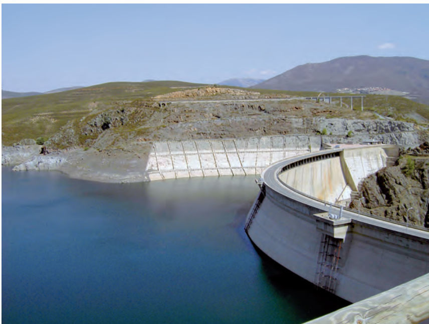
Figura 5. Muro de contención de un embalse
