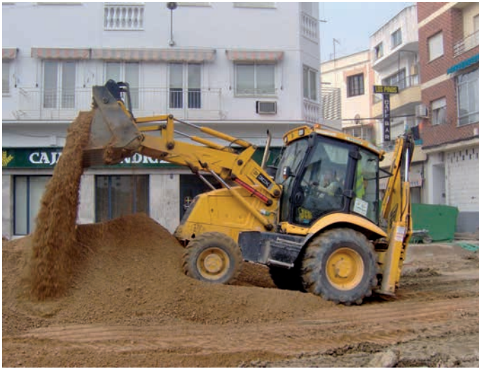
Figura 4. Maquinaria de movimiento de tierras: retroexcavadora
