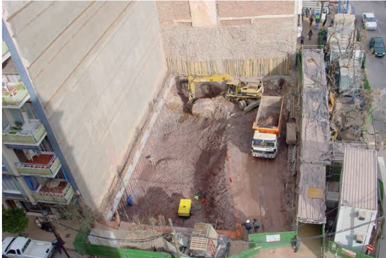
Figura 2. Replanteo de un movimiento de tierras
