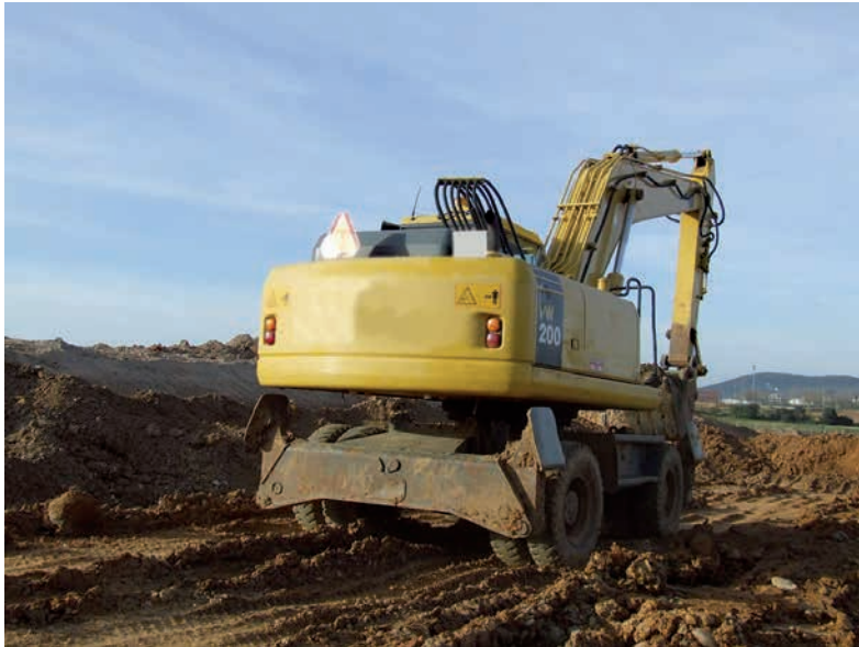
Figura 1. Excavadora sobre ruedas realizando trabajos de desbroce
