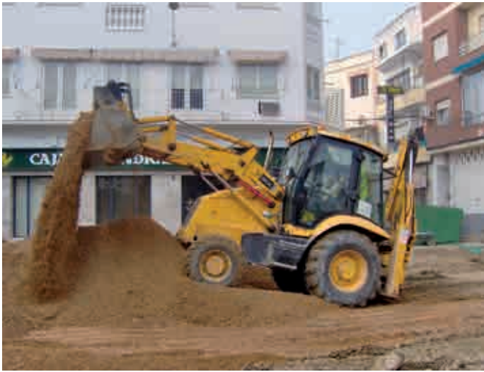
Figura 4. Maquinaria de movimiento de tierras: retroexcavadora
