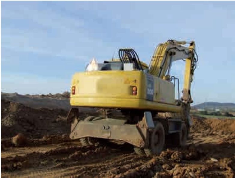
Figura 1. Excavadora sobre ruedas realizando trabajos de desbroce
