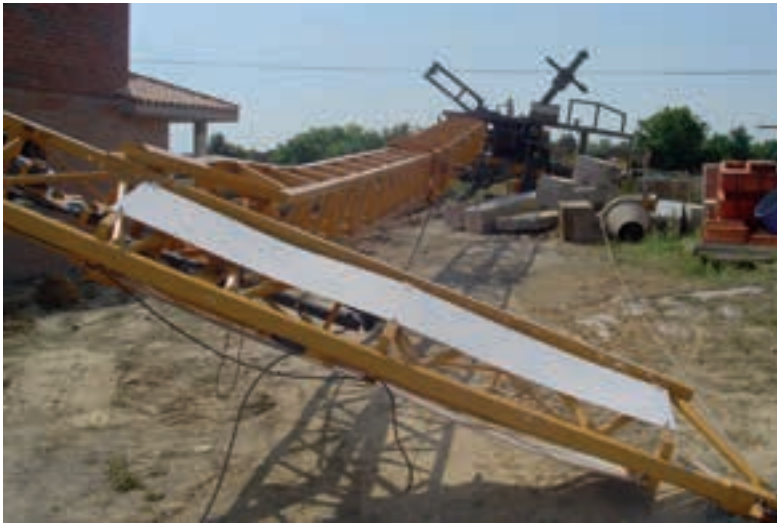
Figura 1. Accidente de grúa autodesplegable
