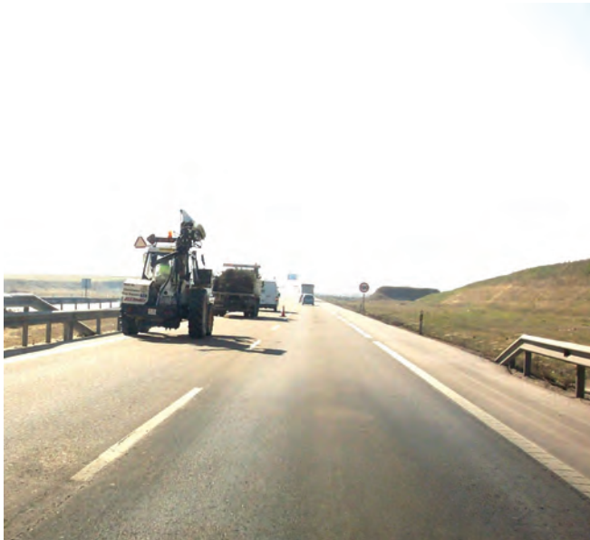
Figura 3. Operaciones de conservación ordinaria
