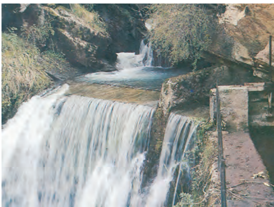
Figura 10. Proceso indirecto geofísico. Captación de agua para una minicentral eléctrica. Fuente: GdE. Generación de energía, S.A
