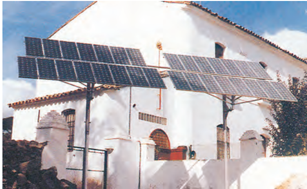
Figura 7. Proceso directo fotovoltaico. Paneles fotovoltaicos en una vivienda rural. Fuente: JO-GA-SO. S.L
