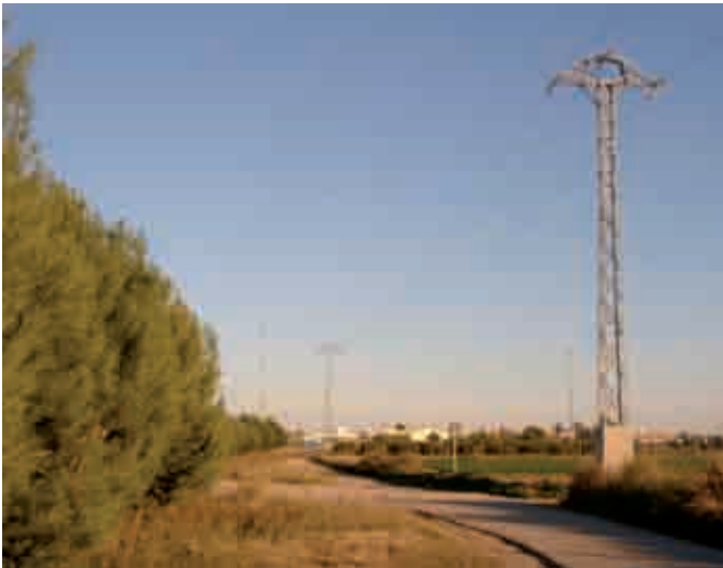
Figura 4. Línea aérea eléctrica en una parcela
