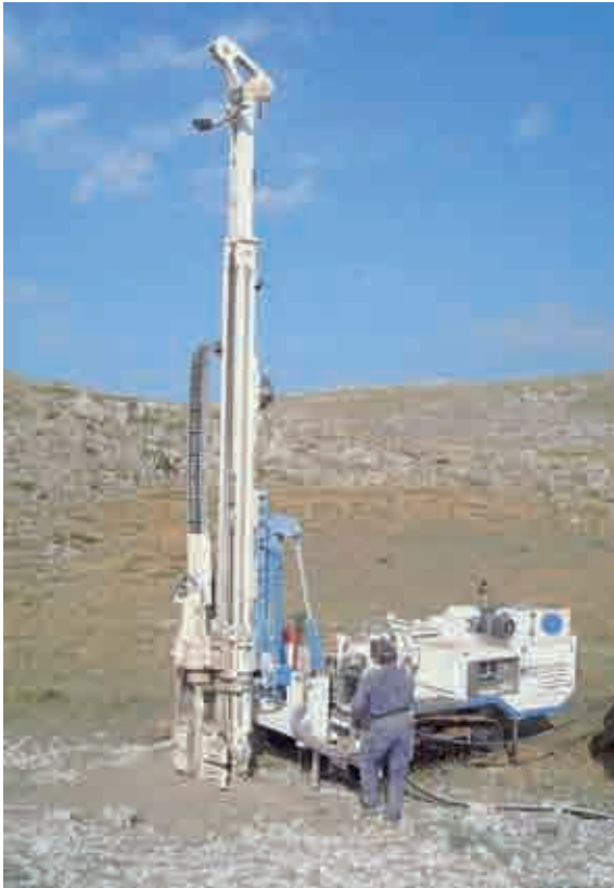
Figura 2. Maquinaria para la perforación geotécnica
