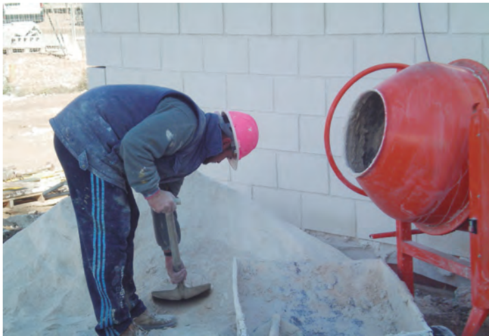
Figura 1. Elaboración de un mortero en el tajo mediante dosificación manual y mezclado y amasado mecánicos.
