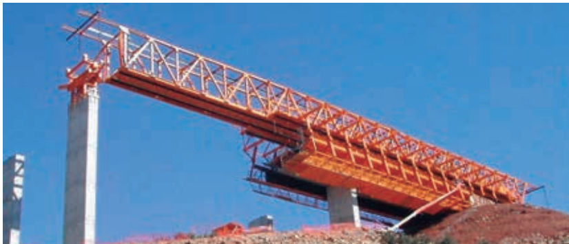
Figura 15. Viaducto Albentosa (Teruel) vanos de 50 m. 2005
