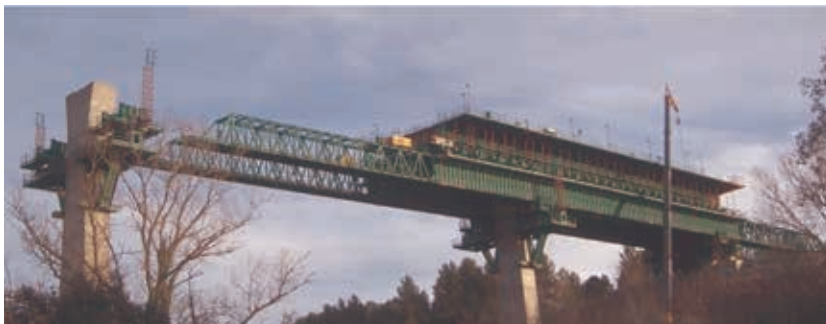
Figura 16. Viaductos LAV tramo Figueras – Frontera. Vanos de 60 m de luz
