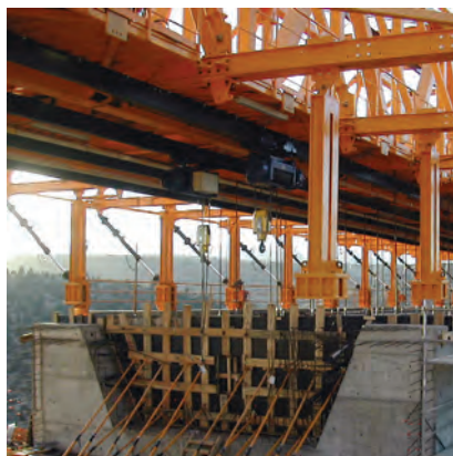
Figura 6. Autocimbra sustentada en la parte superior
