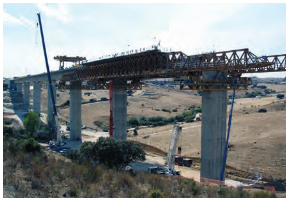
Figura 4. Autocimbra sustentada en la parte inferior
