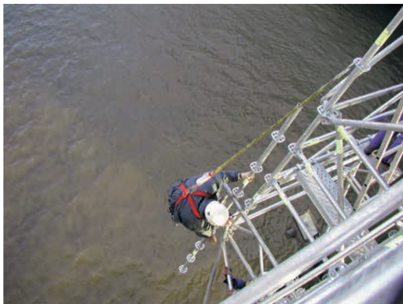
Figura 2. Trabajador en andamio cumpliendo las normas de seguridad
