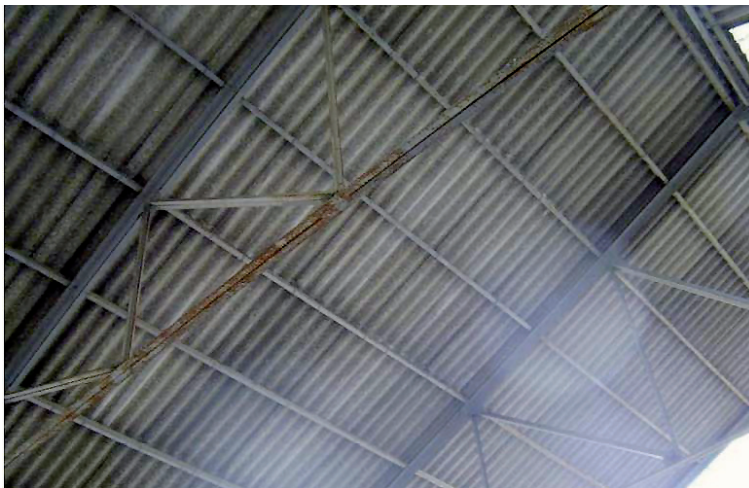
Figura 9. Cubierta de fibrocemento. Fuente: IGR, S.A.
