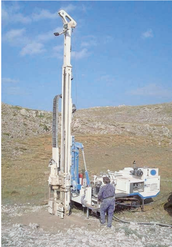
Figura 2. Maquinaria para la perforación geotécnica
